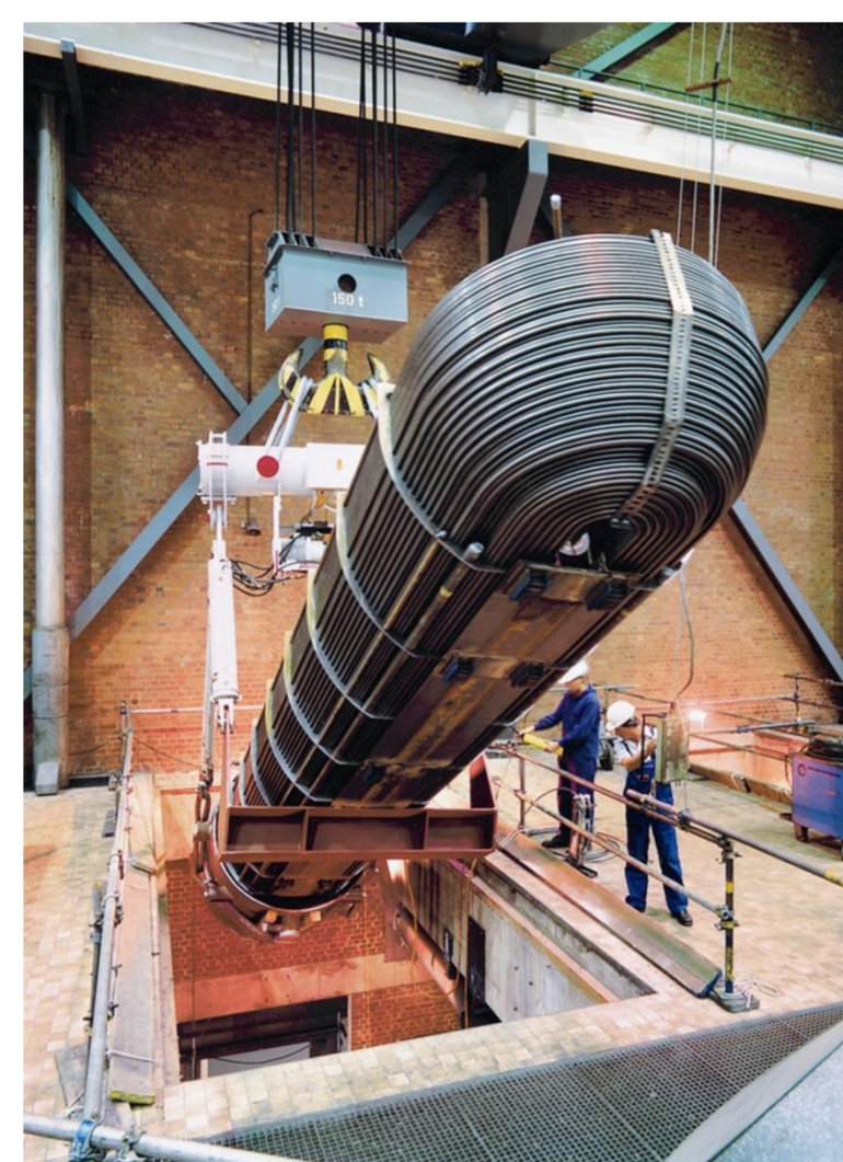
Obr. 1: Regenerační ohřívák napájecí vody
